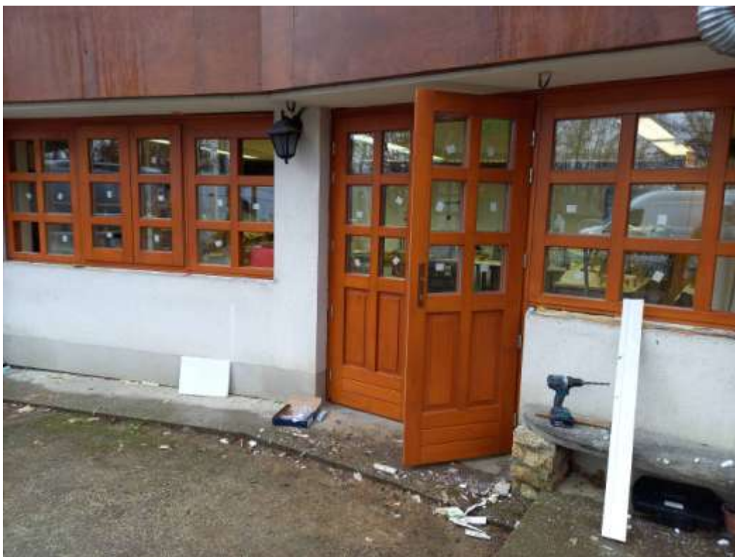
A szálasanyag műhely munka közben és a beépített új nyílászárókkal.
