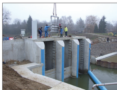
Zsilipek és mobil elzárások duzzasztóműben
