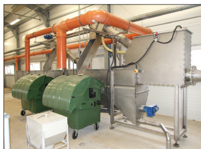
STU Kompakt szennyvíz előkezelő
