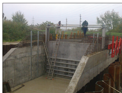
Duplatáblás zsilip beépítése
