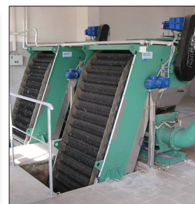
SCC Öntisztító gépi síkrács
