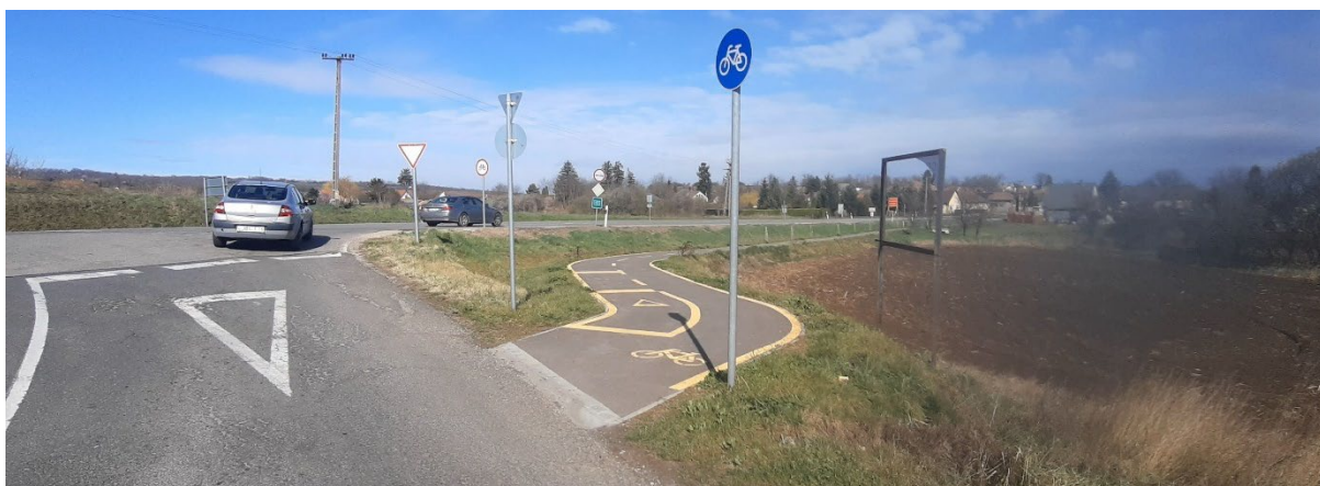
Kerékpárút vége a dégi elágazásnál. Saját fotó
