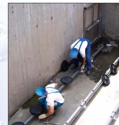
Tányér levegőztető fejek szerelése
