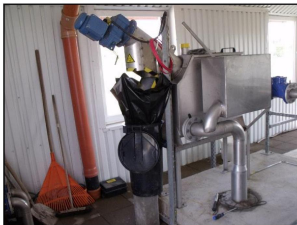
Gépi rács és kézi rács megkerülőággal
