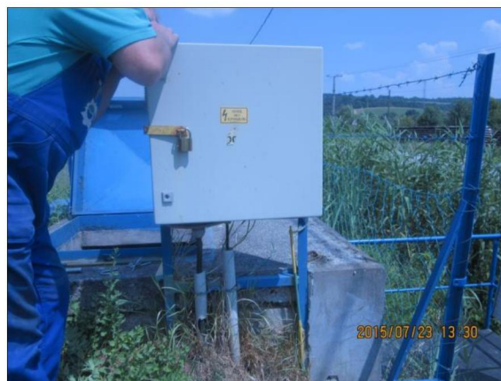
Kútszivattyú vezérlése
