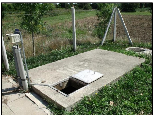
Tisztított szennyvíz mérőakna
