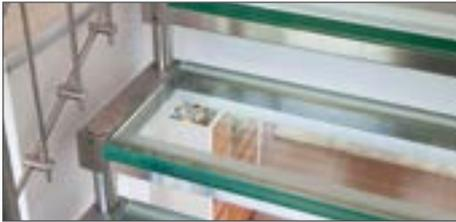
**WIKO GLAS-METALL KLEBSTOFF** ist ein ein-komponentiger, anaerober Klebstoff, der speziell für die Verklebung von Metallen mit Glas eingestellt wurde.
